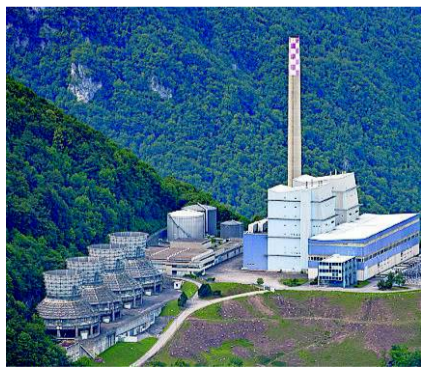
Gaskraftwerk Chavalon. KEY
